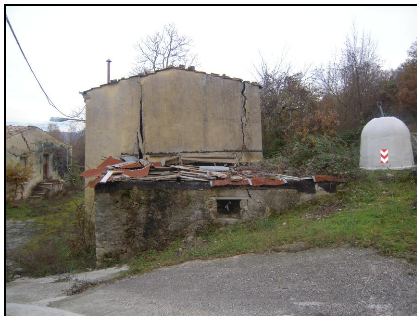
Fig. 8 – Veduta di un'abitazione interessata da un fenomeno di dissesto in località S. Rita a sud del centro storico.
