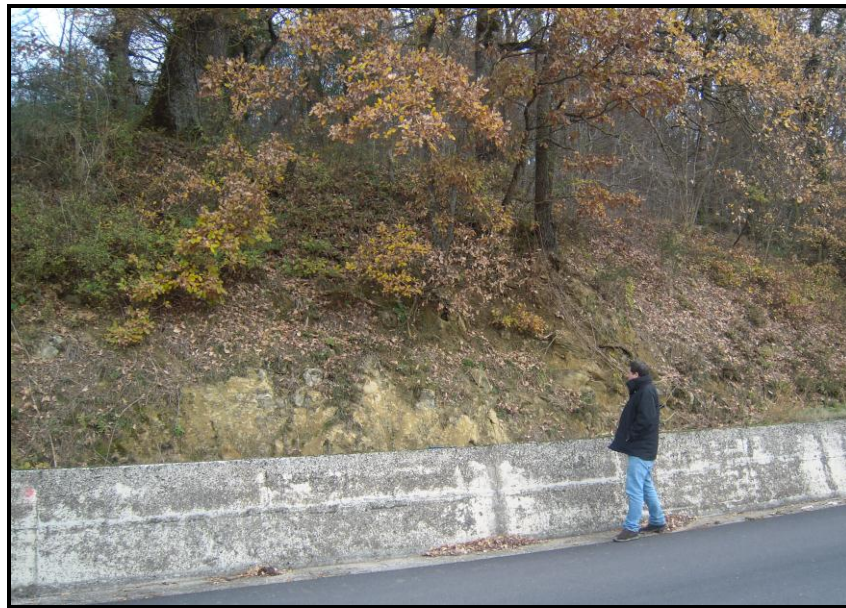
Fig. 5 – Arenarie e sabbie stratificate della Formazione del Flysch del Molise, appartenenti alla sottoclasse ALS (b) del substrato costituito da un'Alternanza di Litotipi Stratificati, in un affioramento nei pressi del centro storico ed a W della “Borgata Papaccio”.
