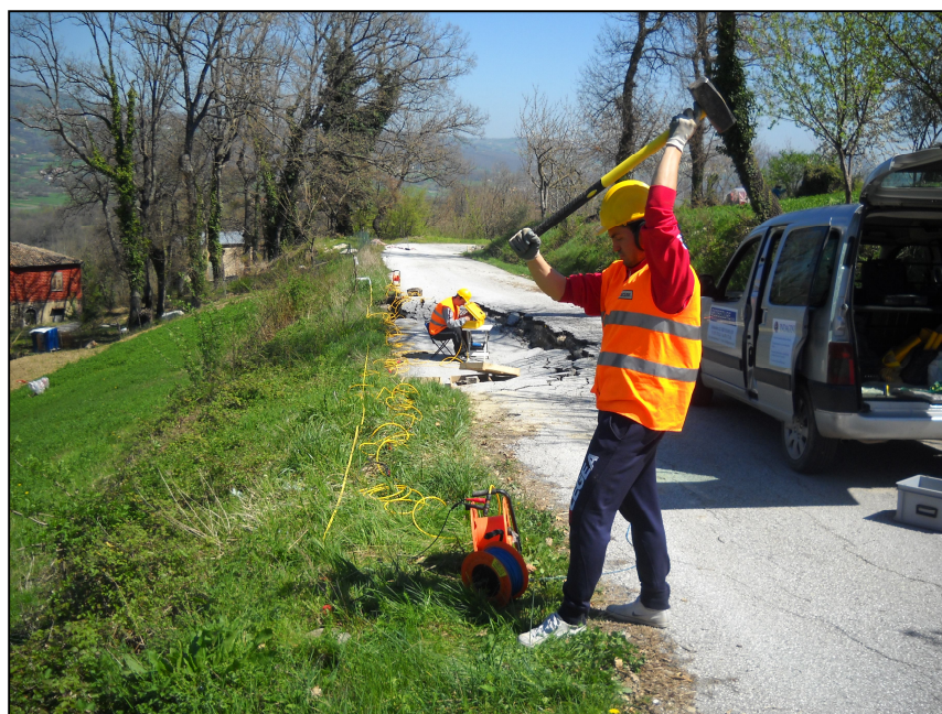
FOTO 1: particolare dell'esecuzione della prospezione.
